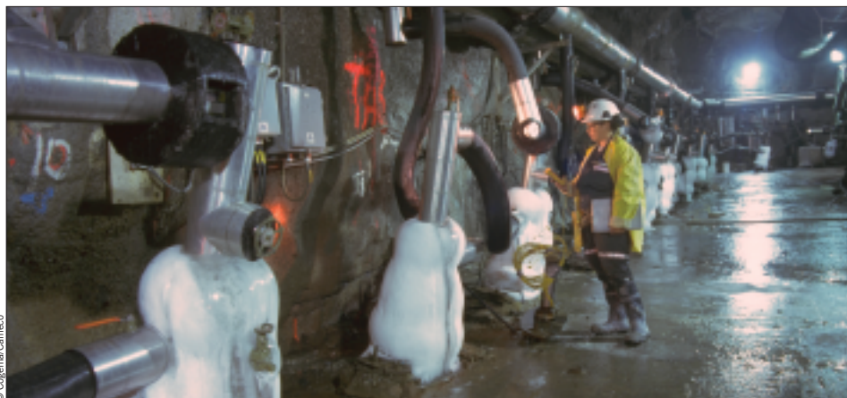
Foration montante en terrain congelé dans la mine de McArthur (Canada).
