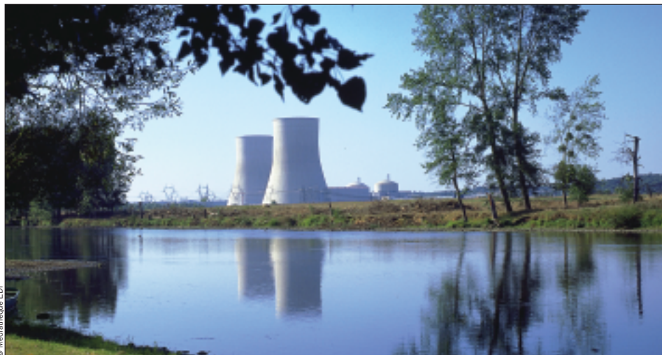
La centrale nucléaire de Civaux (Vienne).
